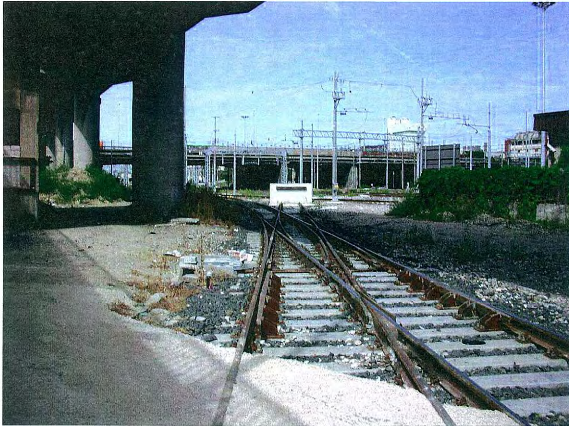
Percorso di accesso all'area di lavoro a partire dal cantiere operativo.
