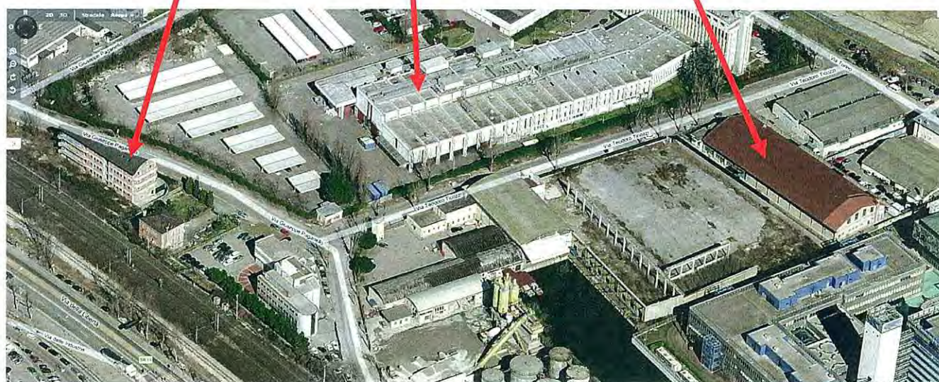
Figura 11.13- vista degli edifici interferenti imbocco lato Mestre.
